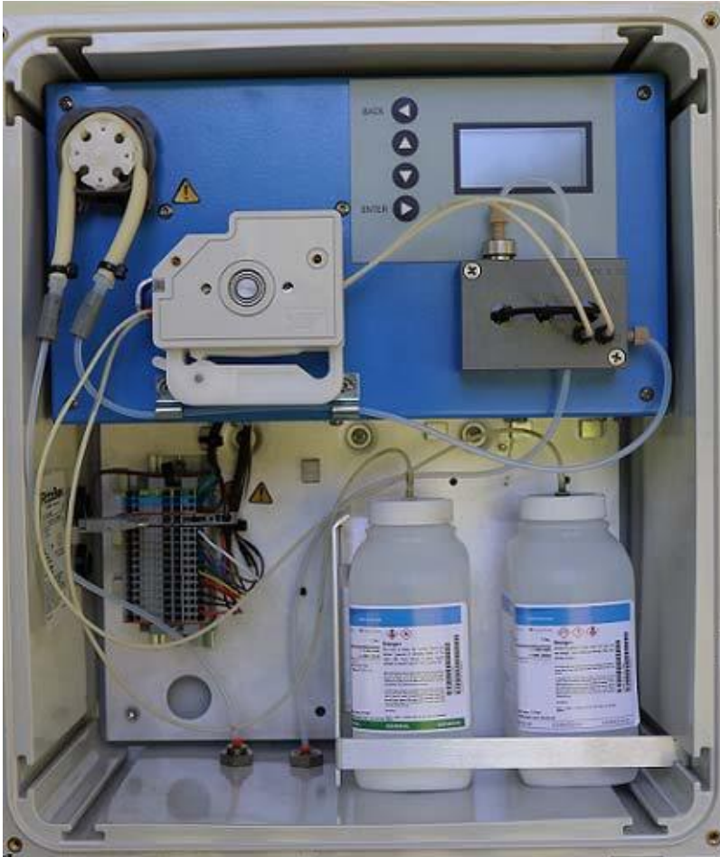
Bild 8.2 Fertig installierte Schläuche
